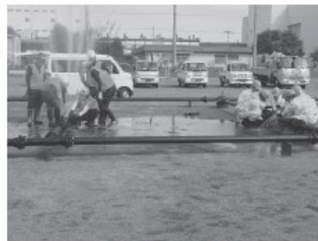
配水管漏水復旧訓練
