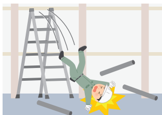
脚立を使用して配管作業中、転落して頭部を打ち死亡。
