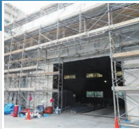
地元にとって必要不可欠な鉄筋に関する工場の改修に活用されました(沖縄)
