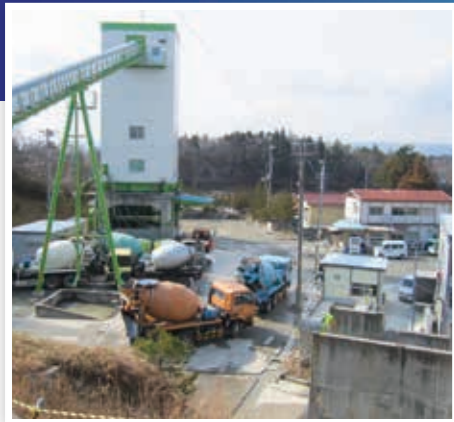
東日本大震災からの復旧工事に必要な生コンプラント関連施設建設に活用されました(福島)
