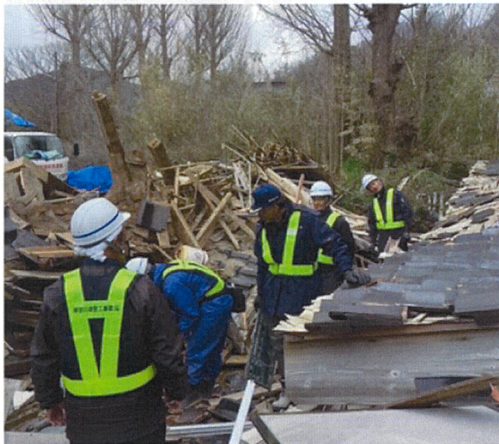
現地の作業の様子(市管工事組合提供)
