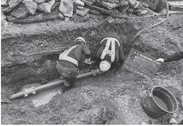
2月15日志賀町(神奈川県管工事業協同組合)
