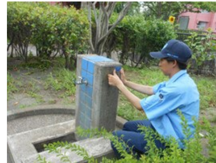
給水装置完了検査
