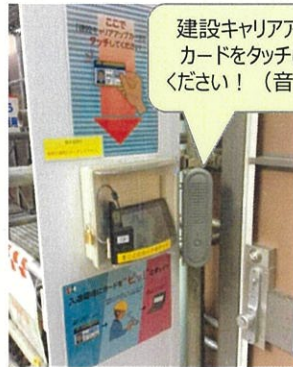
人感センサーによるスピーカ-を設置して、技能者に自動呼びかけ
