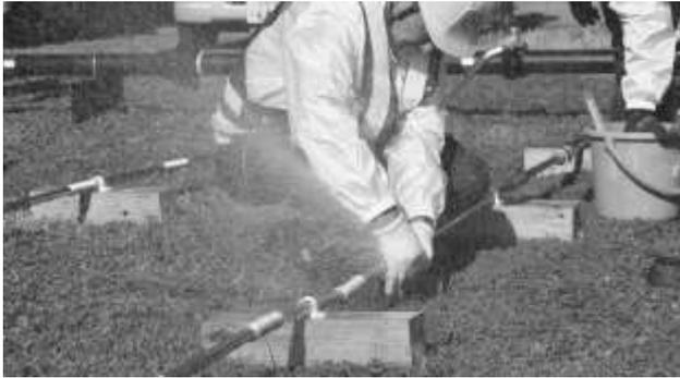
給水管を切断して断水コマで応急止水をする作業
