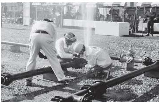
配水管漏水修理(宇管工青年部)
