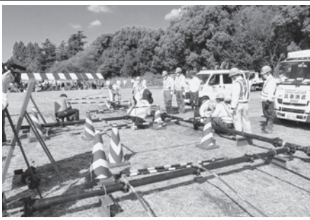
配水管小管部分の漏水復旧訓練
