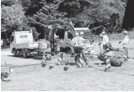
道路啓開訓練
