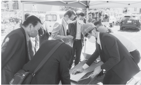
PC上で施工現場の状況を確認
