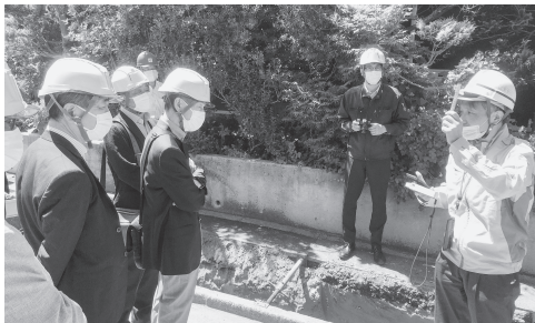
現場視察の様子
