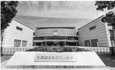
愛媛県民文化会館
