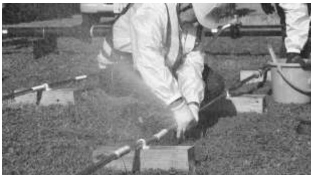
給水管を切断して断水コマで応急止水をする作業
