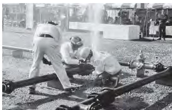
配水管漏水修理(宇管工青年部)
