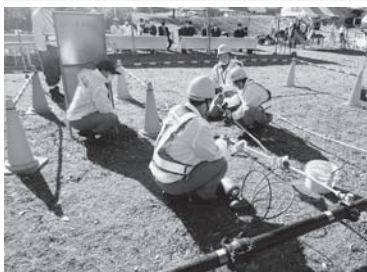
止水栓部分 漏水復旧訓練
