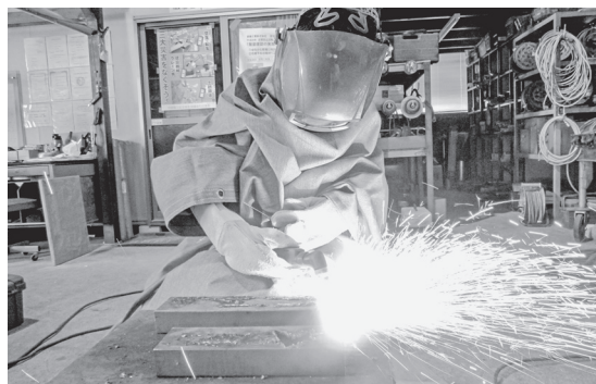
エアープラズマによる金属切断
