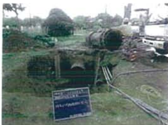
既設φ800mm管の状況
