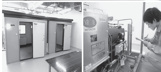
冷暖房性能実習と負荷室 (空気調和実習)
