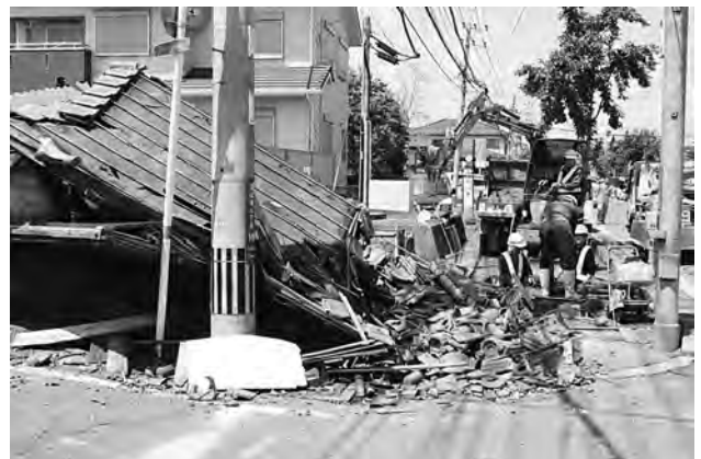
熊本市管工事協同組合（熊本市沼山津地区）
