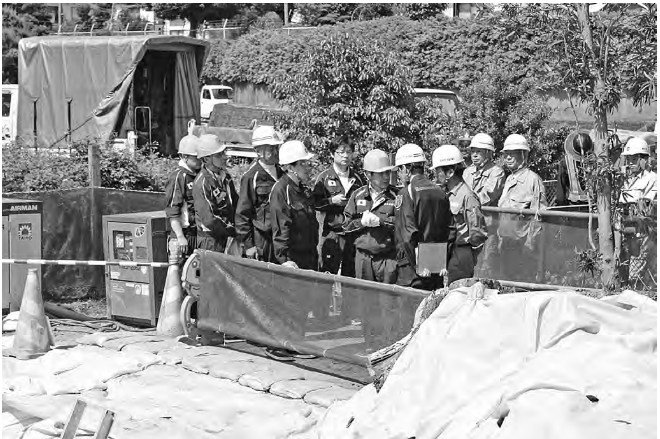
塩崎厚生労働大臣（中央）に説明する大西熊本市長（左から4人目）、熊本市上下水道局の永目事業管理者（同3人目）。大臣の右から2人目から、工藤熊本県連会長、全管連の原災害対策担当理事、松田総務担当副会長（5月1日、熊本市の江津湖公園付近の健軍・秋田水系1,350mmの送水管立坑）
