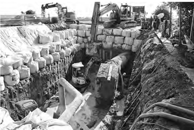
熊本市管工事協同組合 (熊本市江津湖公園付近) (23頁と同じ現場)
