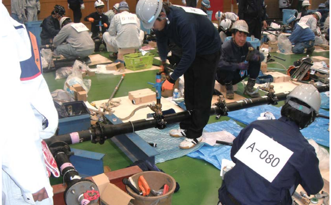
給水装置工事配管技能者検定の開催に協力
