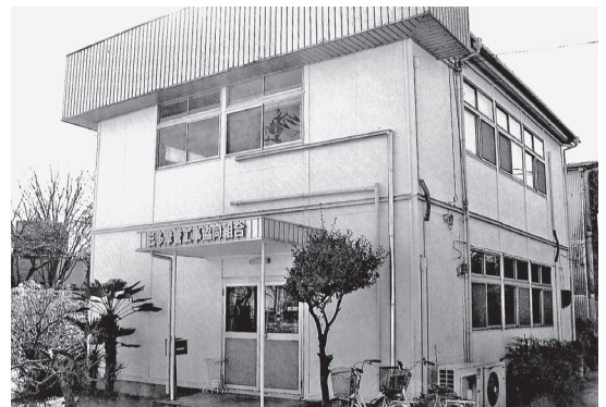
三多摩管工事協同組合事務所
