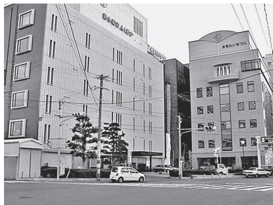
福岡市水道局庁舎
