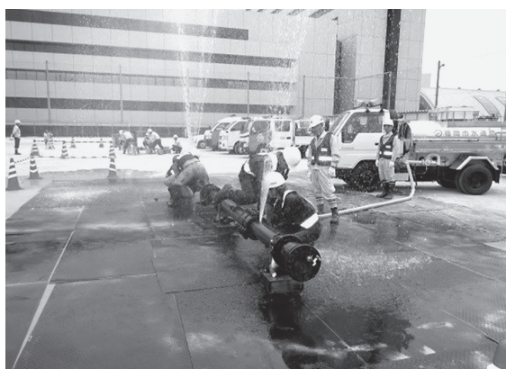
漏水による応急復旧の訓練
