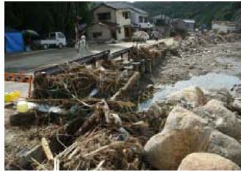
橋梁添架管(上流側より)
