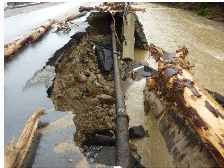
露出している配水幹線2
