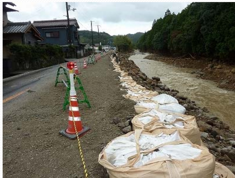
復旧した県道
