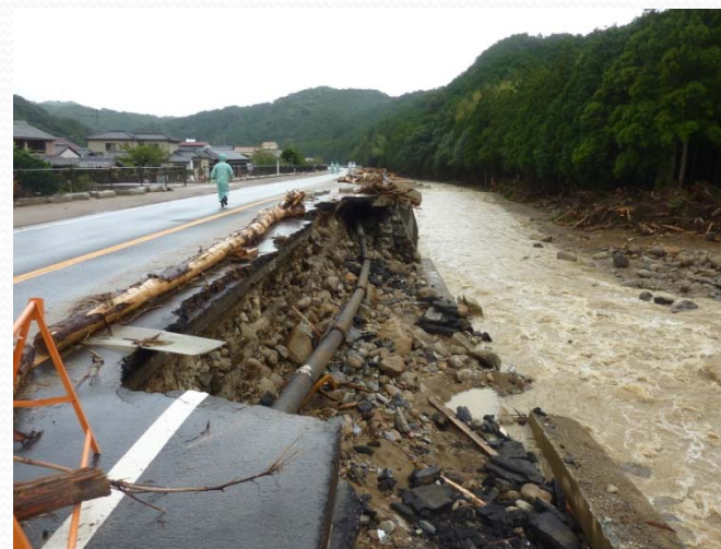
道路の洗掘により川関橋左岸の埋設管及び添架管が露出している
