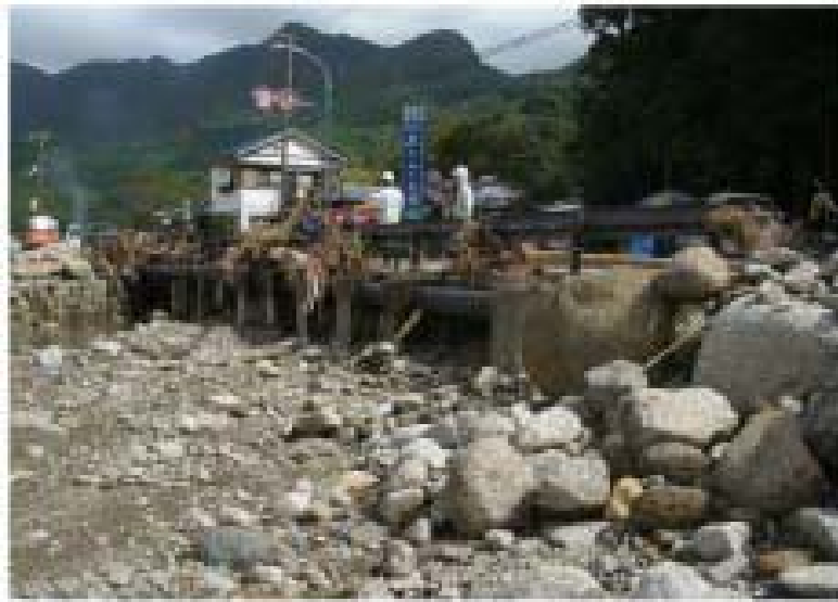
橋梁添架管(下流側より)
