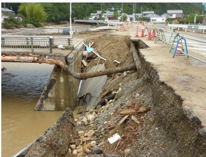
道路の洗掘により川関橋左岸の埋設管及び添架管が露出している
