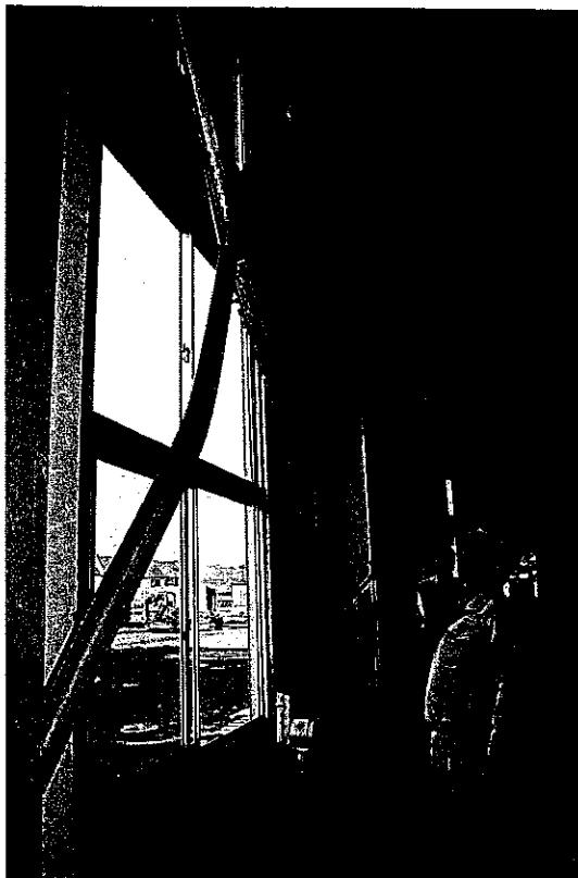
ポンプ棟建屋の補強部材が大きく変形
