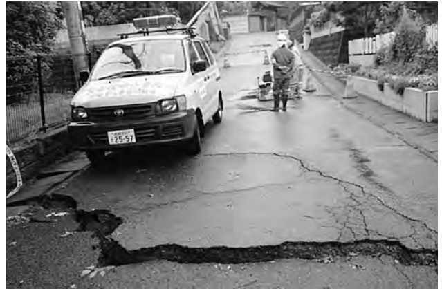
宮崎市上下水道局・宮崎管工事協同組合 (熊本市)
