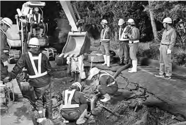
熊本市管工事組合：送水管700mm（バタフライフランジ部）路面漏水修理（熊本市沼山津地区、4月15日22時ごろ。3時間後に震度6強の本震）
